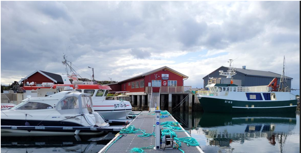
Figur 16 viser området sett fra flytebrygga mot næringsområdet. Her er «rekefabrikken» som i dag benyttes som personalrom/lager og verksted i forgrunn og et nyere lager (blått) til venstre.
