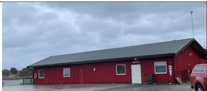
Figur 20 viser "rekefabrikken" fra siden.
