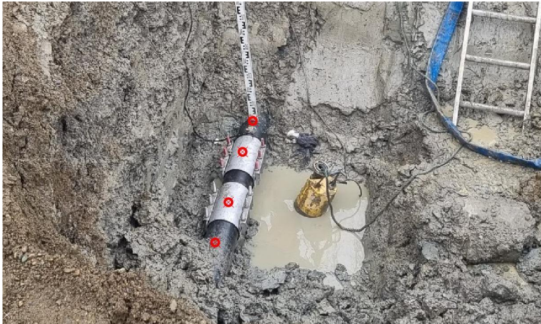
FIGUR 11: EKSEMPEL PÅ INNMÅLING AV REPARASJON. INNMÅLING SENTER TOPP RØR OG SENTER TOPP REPERASJONSMUFFE.
