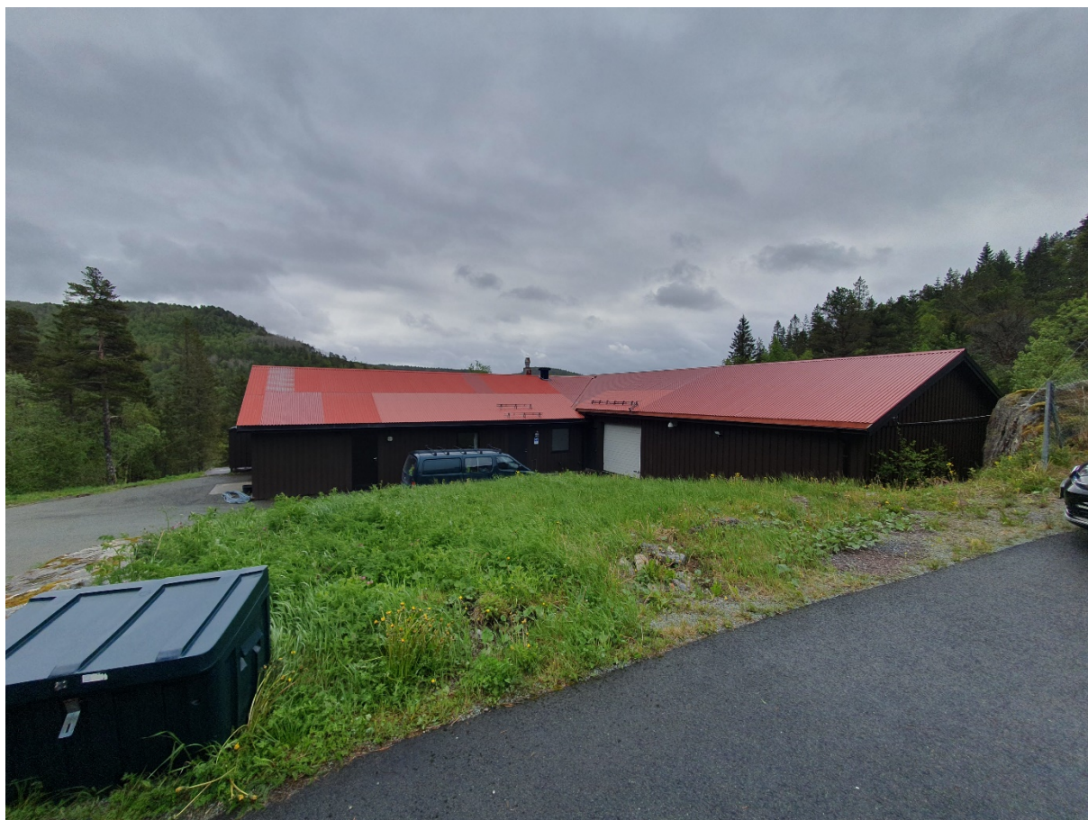
Figur 11: Vannbehandlingsanlegget i Ørland kommunale vannverk
