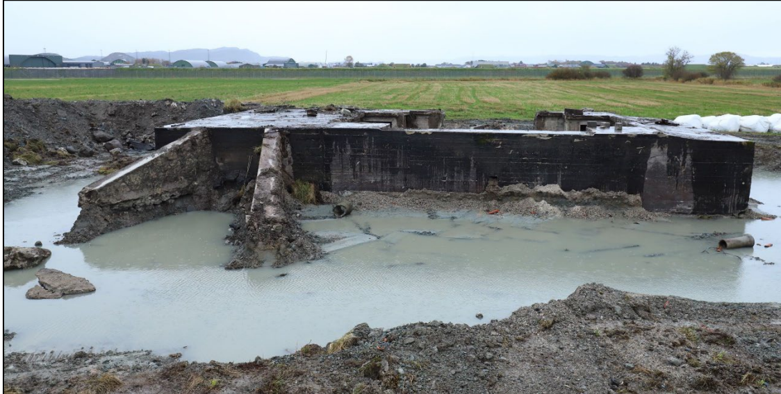
Figur 8 Anlegg 3 sett mot Ø. Foto: Jørn Iver Nicolaysen © 2024
