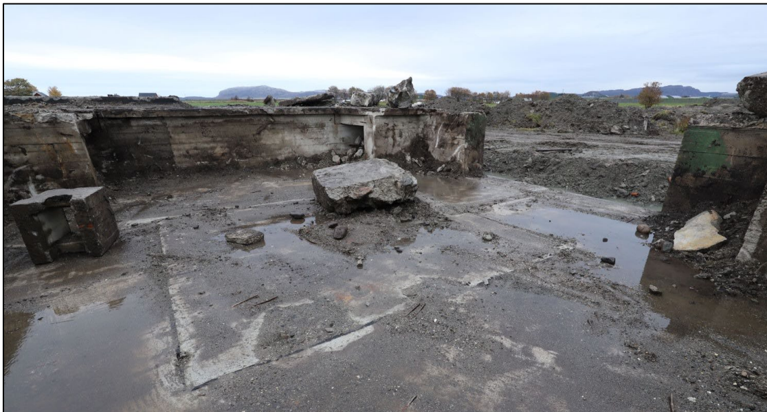
Figur 3 Anlegg 1 sett mot NØ. Kvadratisk kanonstandplass sentralt i bildet, men renne for kabler i golvplanet mot inngangen til høyre. I hver av kanonstandplassens langsider var en utsparing/nisje synlig i toppen. Betongen omkring kanonstandplassen i golvplanet er fra ombygging etter okkupasjonen. Foto: Jørn Iver Nikolaysen © 2024
