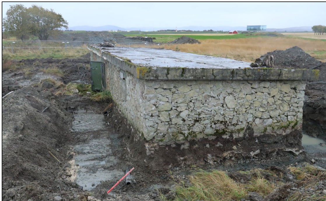
Figur 10 Anlegg 5 sett mot SØ. Anlegg 11-12 ses i bakgrunnen til høyre. Foto: Jørn Iver Nikolaysen © 2024
