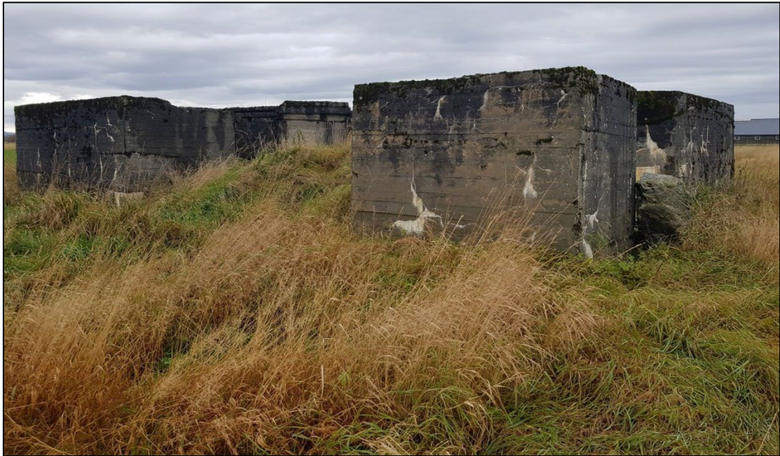
Figur 17 Anlegg 9 sett mot SV. Foto: TRFK
