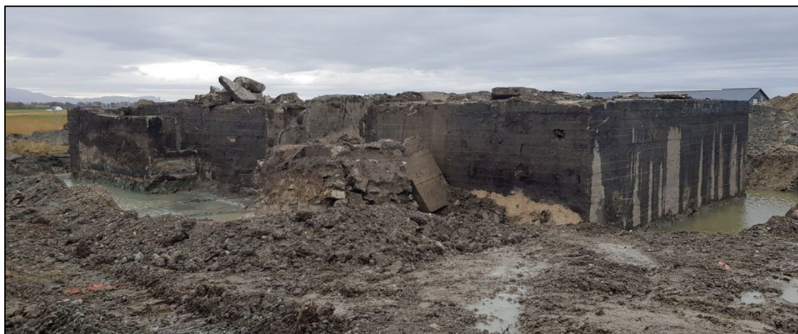
Figur 13 Anlegg 6 sett mot SV. Foto: Jørn Iver Nikolaysen © 2024
