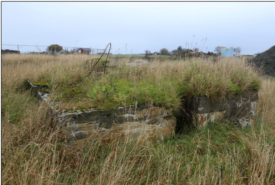
Figur 14 Anlegg 7 sett mot S. Foto: Jørn Iver Nikolaysen © 2024
