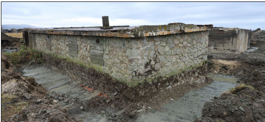
Figur 9 Anlegg 4 sett mot SV. Anlegg 5B bak til høyre. Foto: Jørn Iver Nikolaysen © 2024
