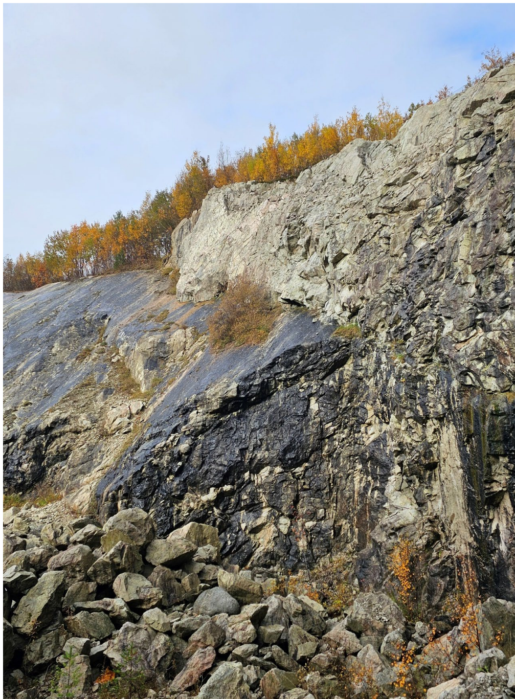
Figur 9 Plan utglidning i overgangen mellom nordveggen og kortveggen. Bildet er tatt mot nord.
