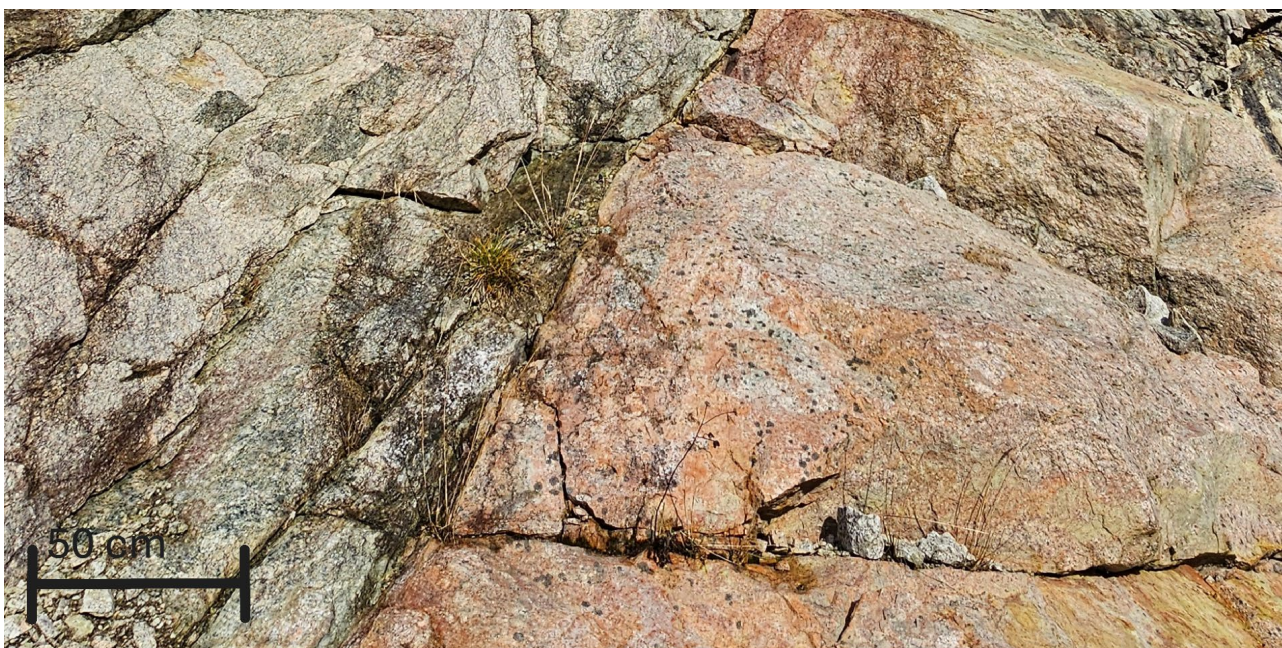
Figur 3 Bilde av bergmassen i nordveggen.
