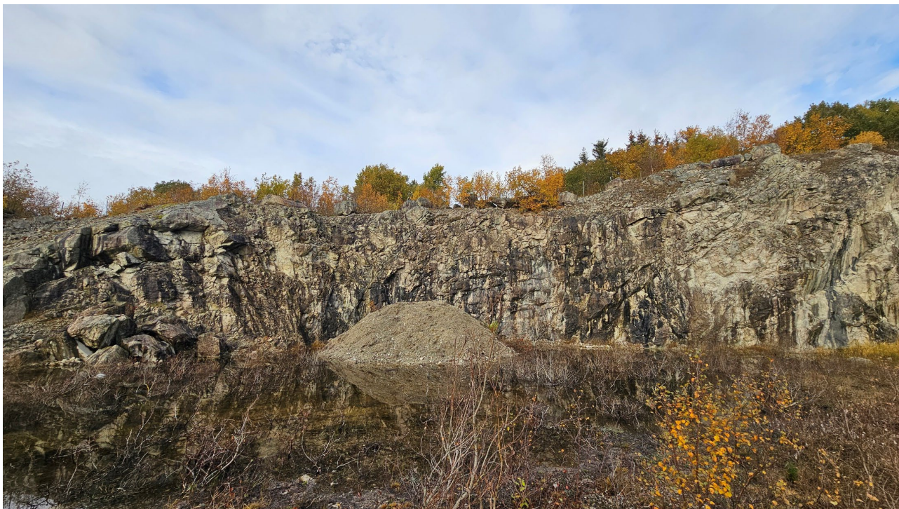
Figur 2 Nordveggen, omtrent ved 50-150m, med vannspeil i front. Bildet er tatt mot nordvest.
