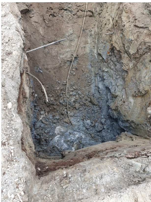
Figur 17: Prøvegraving, berg på cirka 3,2 m dybde.
