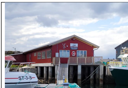
Figur 19 viser "rekefabrikken" mot gavl.
