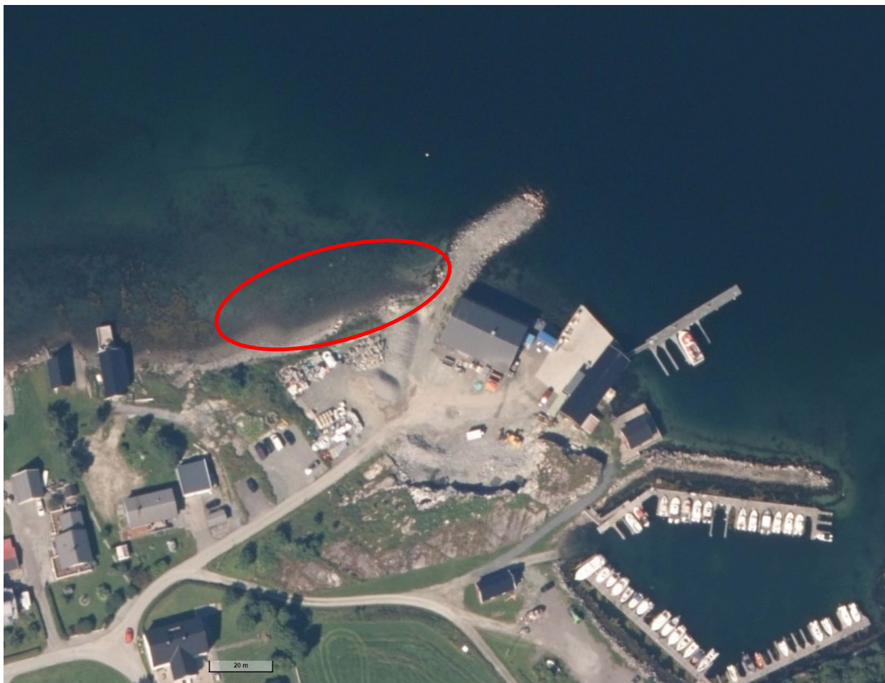
Figur 1 Eiendommen 85/85 i Vallersund, Trøndelag. Bildet viser le-molo under etablering og rød sirkel indikerer planlagt areal for utvidelse av lager/parkeringsplass (Norgeskart.no 11. september 2023)
