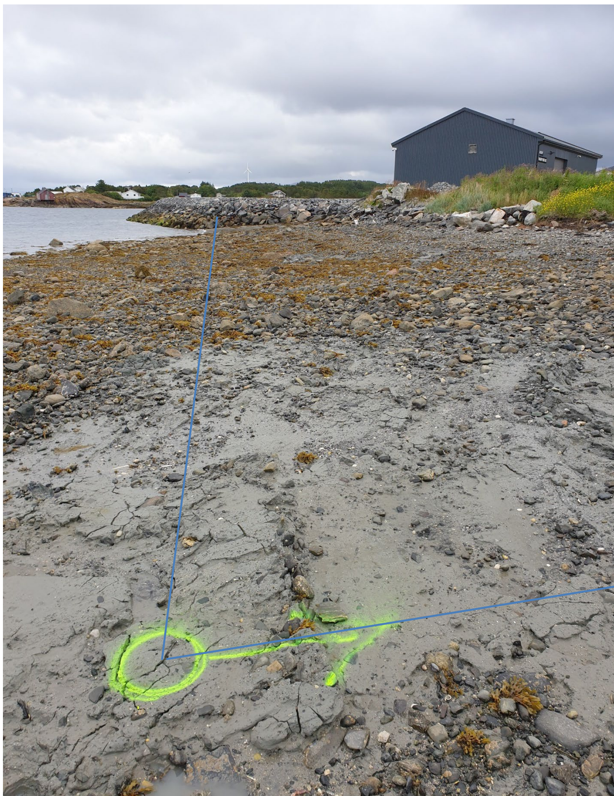
Figur 5 Nordvestlige hjørne (punkt 2 i figur 2) av planlagt utfyllingsområde sett mot øst. I bakgrunnen ses etablert le-molo og drifts/lagerbygg. Bildet er tatt 4. august 2023 kl 19:06. Fyllingsfronent vil få samme utforming som moloen bakerst i bildet, og vil gå langs en rett linje omtrent som vist med blå linje i bildet.
